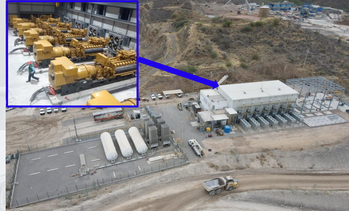
Santa Elena's LNG Power Plant
