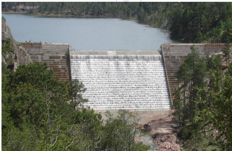
Las Truchas Hydro Electric Dam
