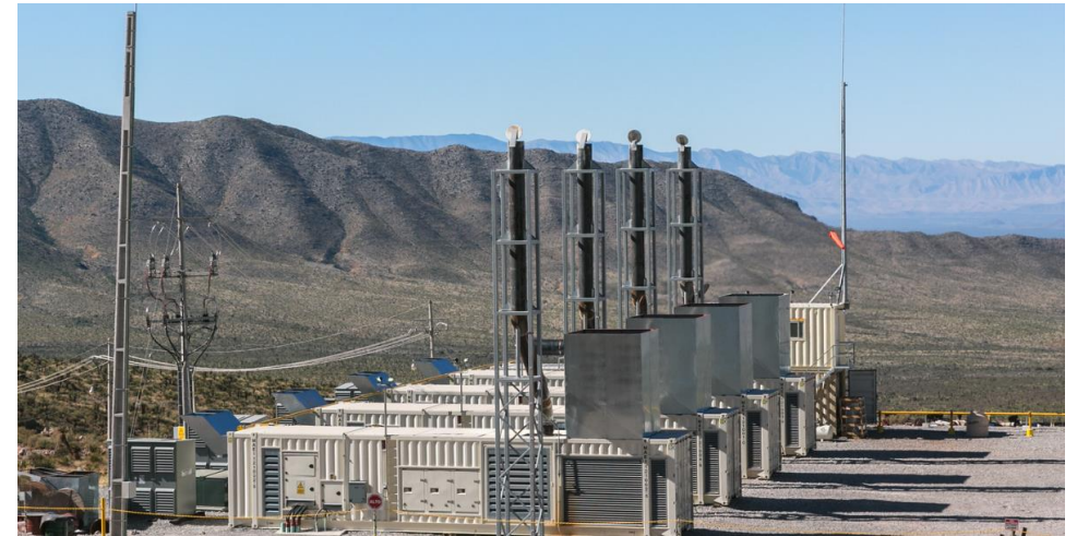
LNG Gensets at La Encantada
